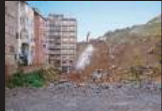
Desmorte entre edificaciones 6.800 m 3 Altura 13 m.
