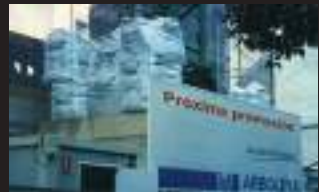
Vaciado entre viejas edificaciones.
